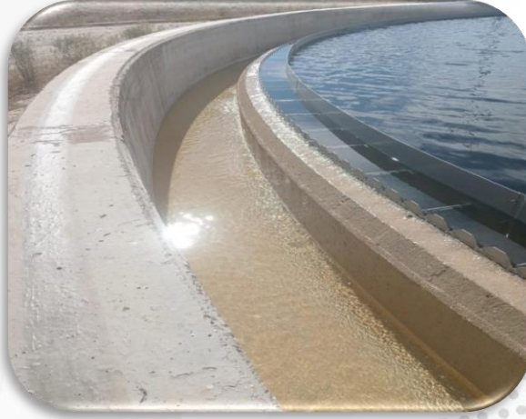
Çökeltme Havuzu Çıkış Suyu
