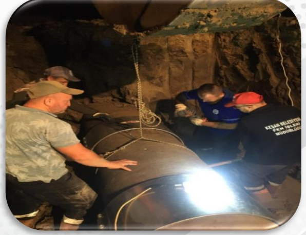
İçme ve Kullanma Suyu Hattı Döşeme Çalışmaları
