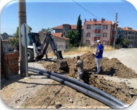
İçme ve Kullanma Suyu Hattı Döşeme Çalışmaları
