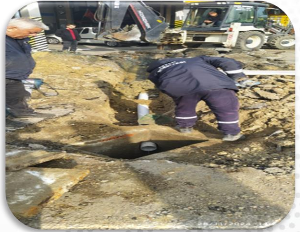
Kanalizasyon Hattı Döşeme Çalışmaları
