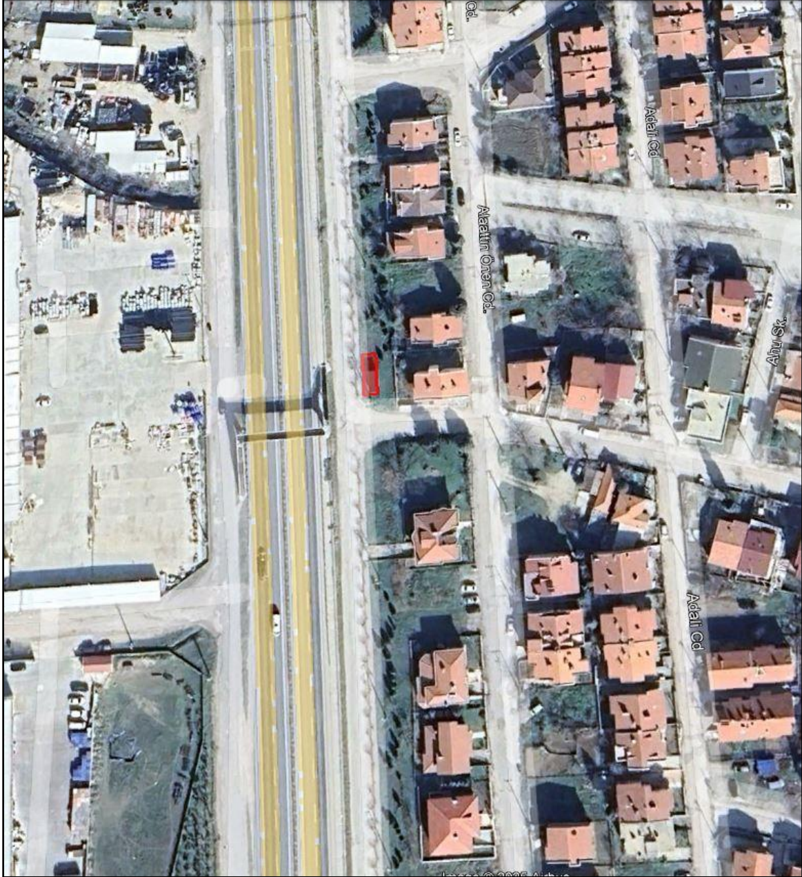
Şekil 1: TR2-03 rumuzlu trafonun konumu
